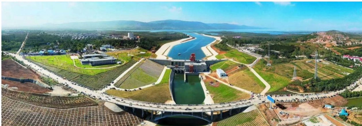
南水北调工程
